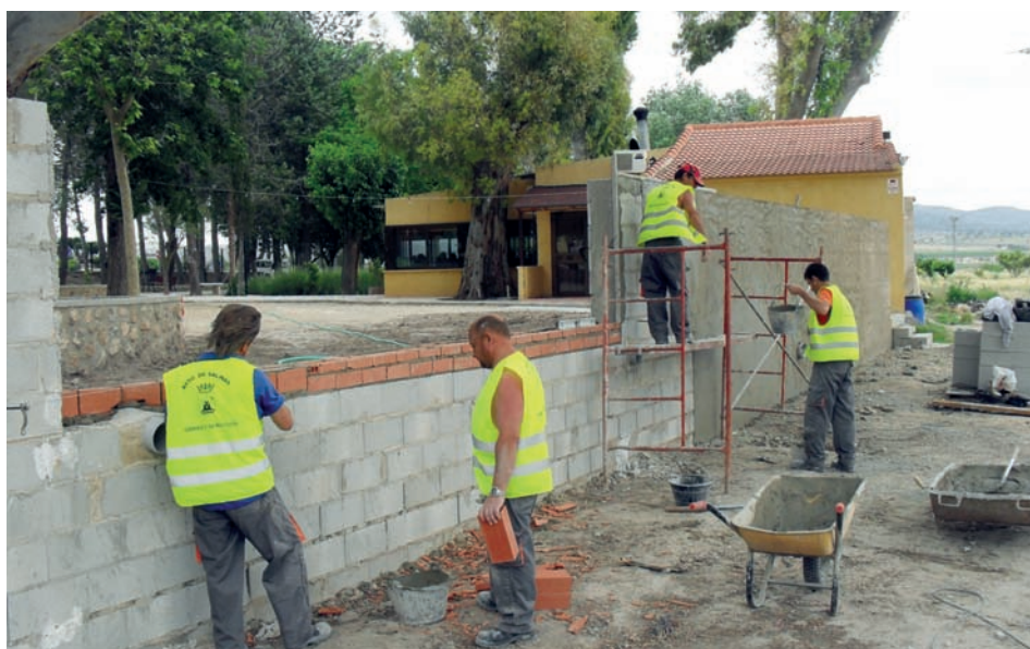
■ Construcción de un muro de contención en el parque de La Rana.
