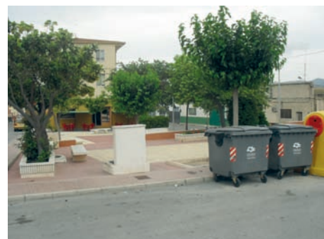
■ Las plazas de San Isidro y Las Minas que, junto a la plaza de España, dispondrán de contenedores soterrados evitando olores y mejorando la imagen del entorno.
