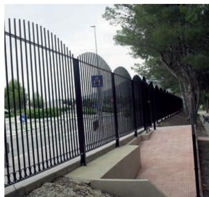
■ Valla de cerramiento en el parque de La Rana.
