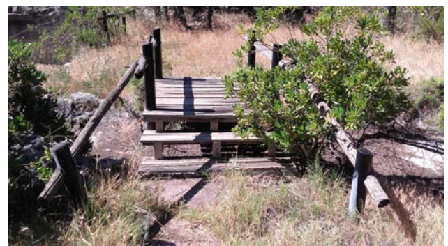
Foto: Puente de madera
