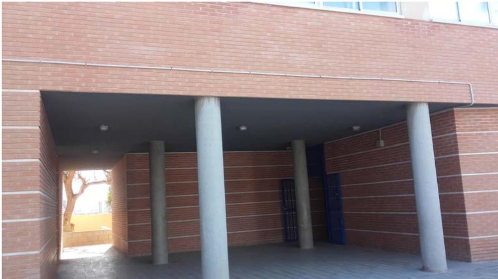
El aula de planta rectangular se sitúa en planta primera del edificio principal del colegio, su forjado inferior se encuentra en contacto con el exterior por el que se producen pérdidas y ganancias energéticas indeseables que afectan al confort del aula.
