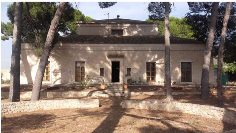
Se trata de una edificación de una planta con aprovechamiento bajo cubierta, cuenta con una superficie construida total de 401,49 m<sup>2</sup>, realizada con materiales y sistemas constructivos de la época (años 85-90), estructura de muros de carga perimetrales en anillo en donde se sitúan las estancias del albergue, dormitorios con baños, cocina y accesos, dejando en su interior un atrio central a doble altura rematado en su parte superior por un lucernario.
