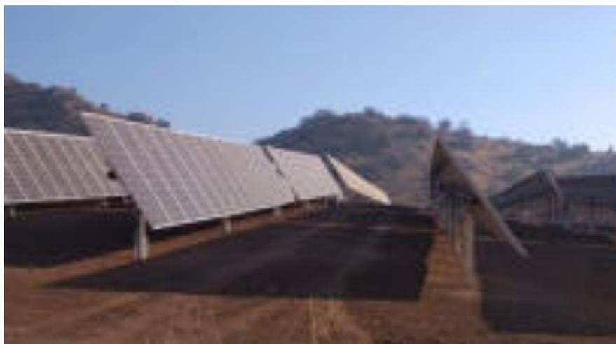
Imagen 86: Ejemplo de seguidores de instalaciones solares fotovoltaicas.
