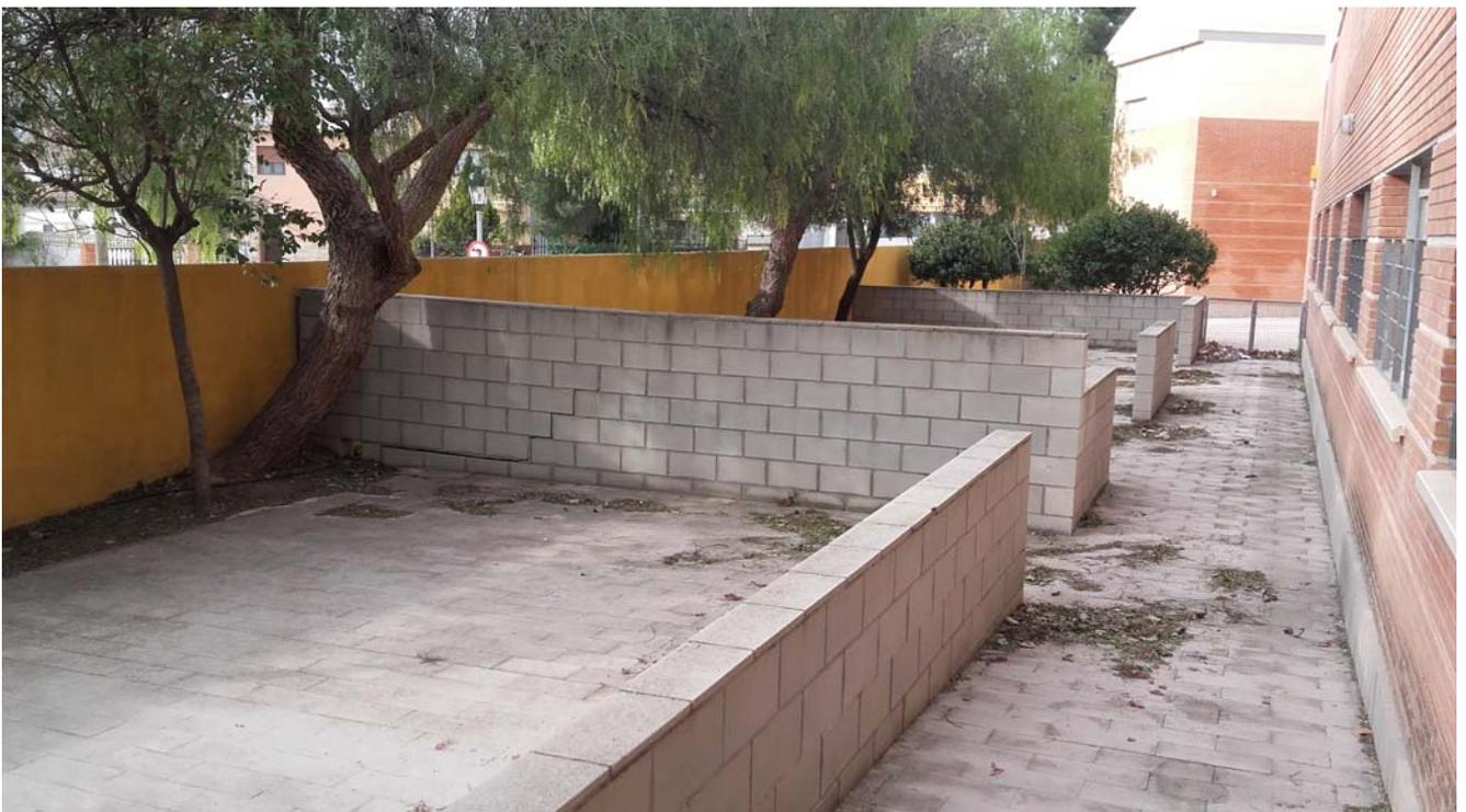
La segunda intervención se realizará en la parte sur del colegio en los denominados "corralitos", se trata de un espacio exterior que presenta una división con cerramiento opaco, alguno de ellos en mal estado con serio peligro de colapso, y el que se pretende dotar de seguridad en cuanto a los elementos constructivos que lo delimitan y a su vez dotar de uso como parque infantil.
